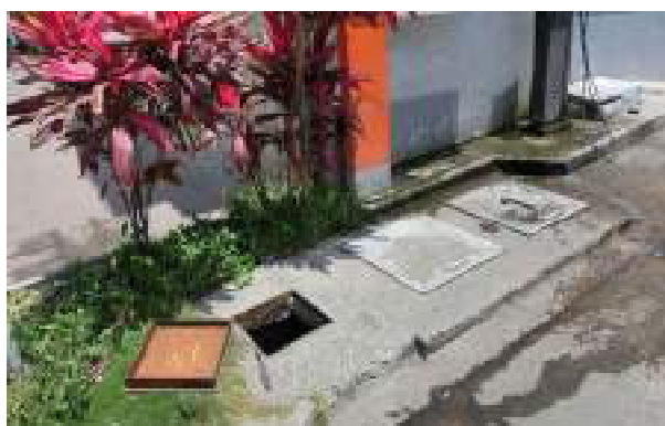
Fotografía 14: Sistema segregado de trampa de grasas de la estación de servicio.
