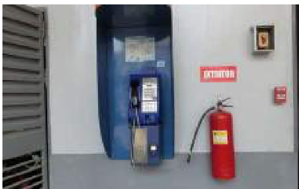
Fotografía 17: Extintor en el área de cuarto de generador.
