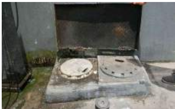
Área de descarga de combustible 1. Se tiene habilitada una sola boca de llenado, de Súper.
