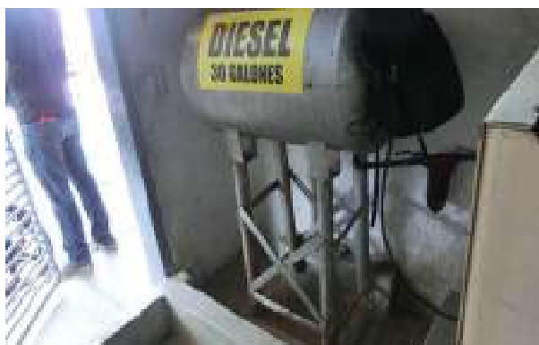
Fotografía 18: Berma de seguridad para el tanque de combustible para el generador eléctrico.
