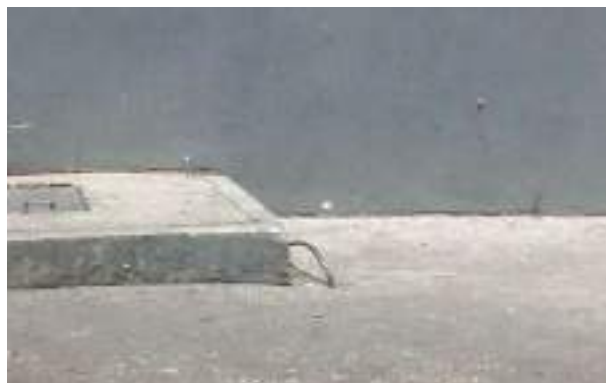
Fotografía 8: Se observa toma a tierra en el área de descarga.
