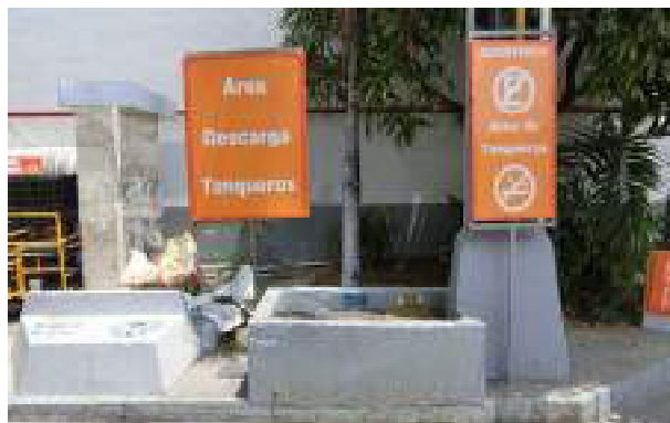
Fotografía 10: Área de descarga de combustible 2. Se tienen habilitadas dos bocas de llenado, de Ecopaís y Diésel.
