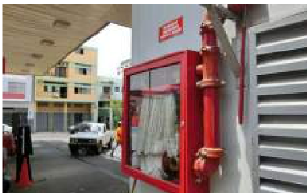
Fotografía 11: Manguera contra incendios en el área de tanques.
