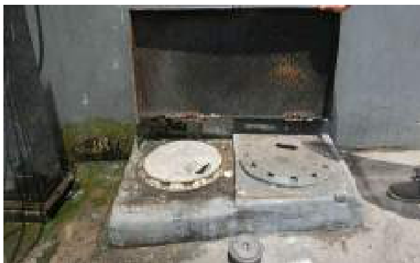
Fotografía 9: Área de descarga de combustible 1. Se tiene habilitada una sola boca de llenado, de Súper.
