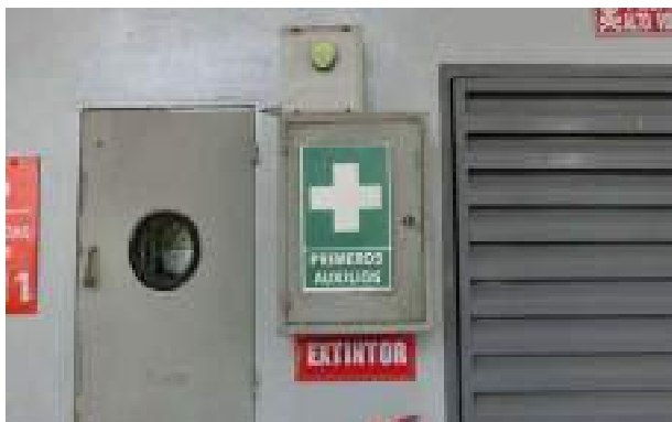
Fotografía 7: Botiquín de primeros auxilios en la marquesina de la estación de servicios.
