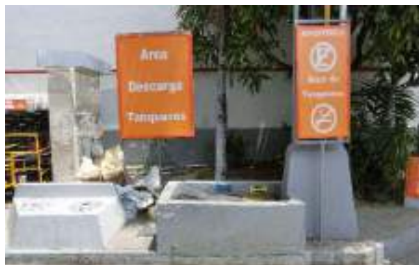
Área de descarga de combustible 2. Se tienen habilitadas dos bocas de llenado, de Ecopaís y Diésel.
